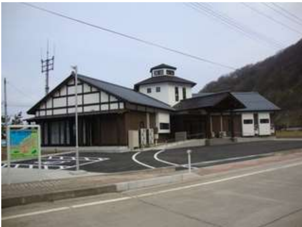
写真 2.1.1 交流拠点施設「さっこい交流館（釜谷地区）」
